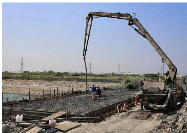
上圖：雲林縣麥寮鄉海埔橋基底混凝土灌漿作業。
